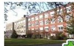
Hümmling Krankenhaus Sögel
